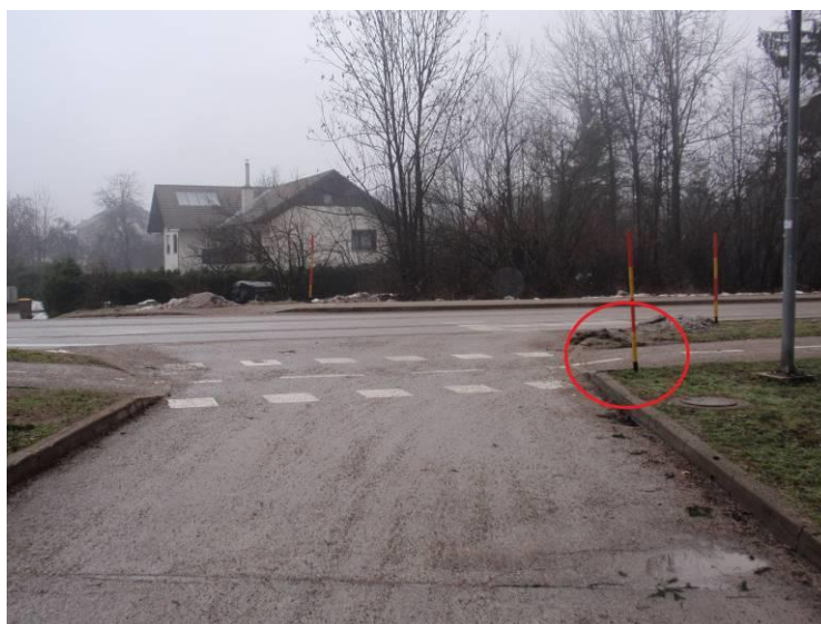
Slika 30: Križišče stranske ceste in izvoz na kolesarsko stezo brez prometnega znaka
